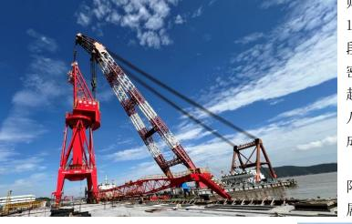
个项目的起重机主体吊装后,安装部调集精锐 力量, 赶赴通州湾佳美海工开展 800T 固定式 门座机的安装工作。迎朝晖、披晚霞, 顶烈日、 战酷暑,利用起吊高度超百米的 2300t 浮吊、 2 台 600 吨汽车吊协作吊装,将佳美 800T 固 定式门座机安全平稳就位。此次吊装最大部件 是转盘总成重达820吨,就位高度达50米, 人字架自重 350 吨,最高吊装点超百米,臂架 部分总长度达 140 米, 在格雷特安装部光荣榜 上再添新绩。 □安装部 王荣荣
